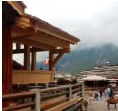
Village d'alpage reconverti. Montriond
