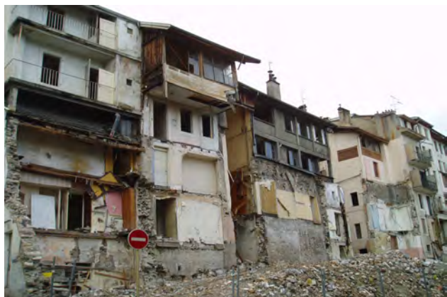
Démolition avant reconstruction de nouveaux immeubles - Evian
