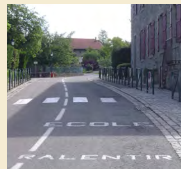
Requalification piétonne et sécurisation des abords d'une école limitant le stationnement abusif sur Champanges
